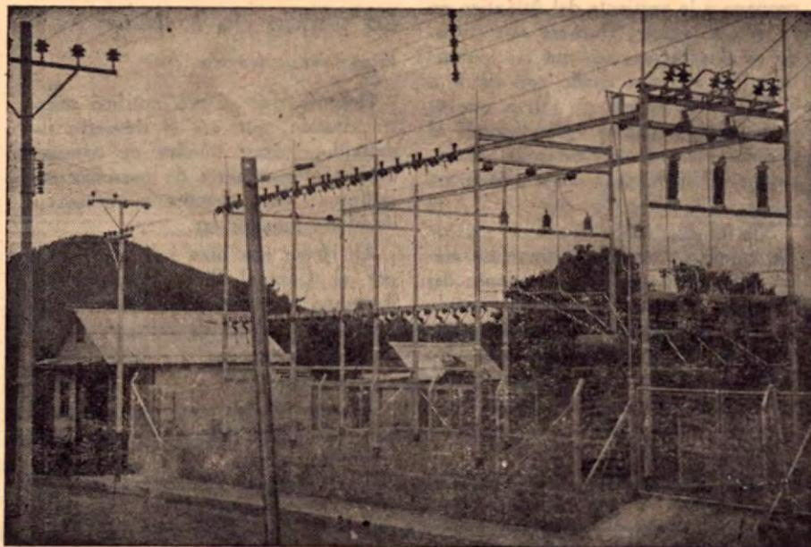
Nueva Sub - Estación reductora y patio de switches de Palmares, Capacidad: 3000 K. V. A.
